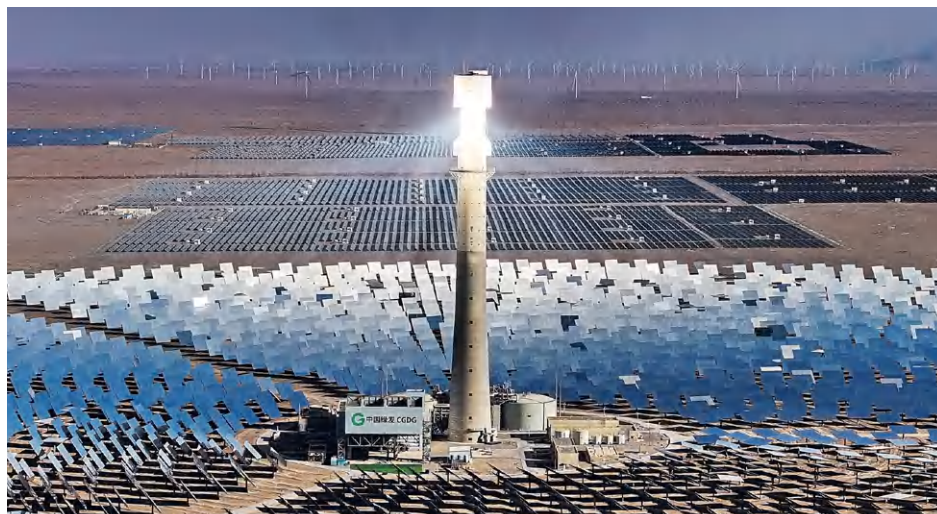
Projet de démonstration du complexe photovoltaïque intégré de Golmud au Qinghai, le 8 décembre 2024
