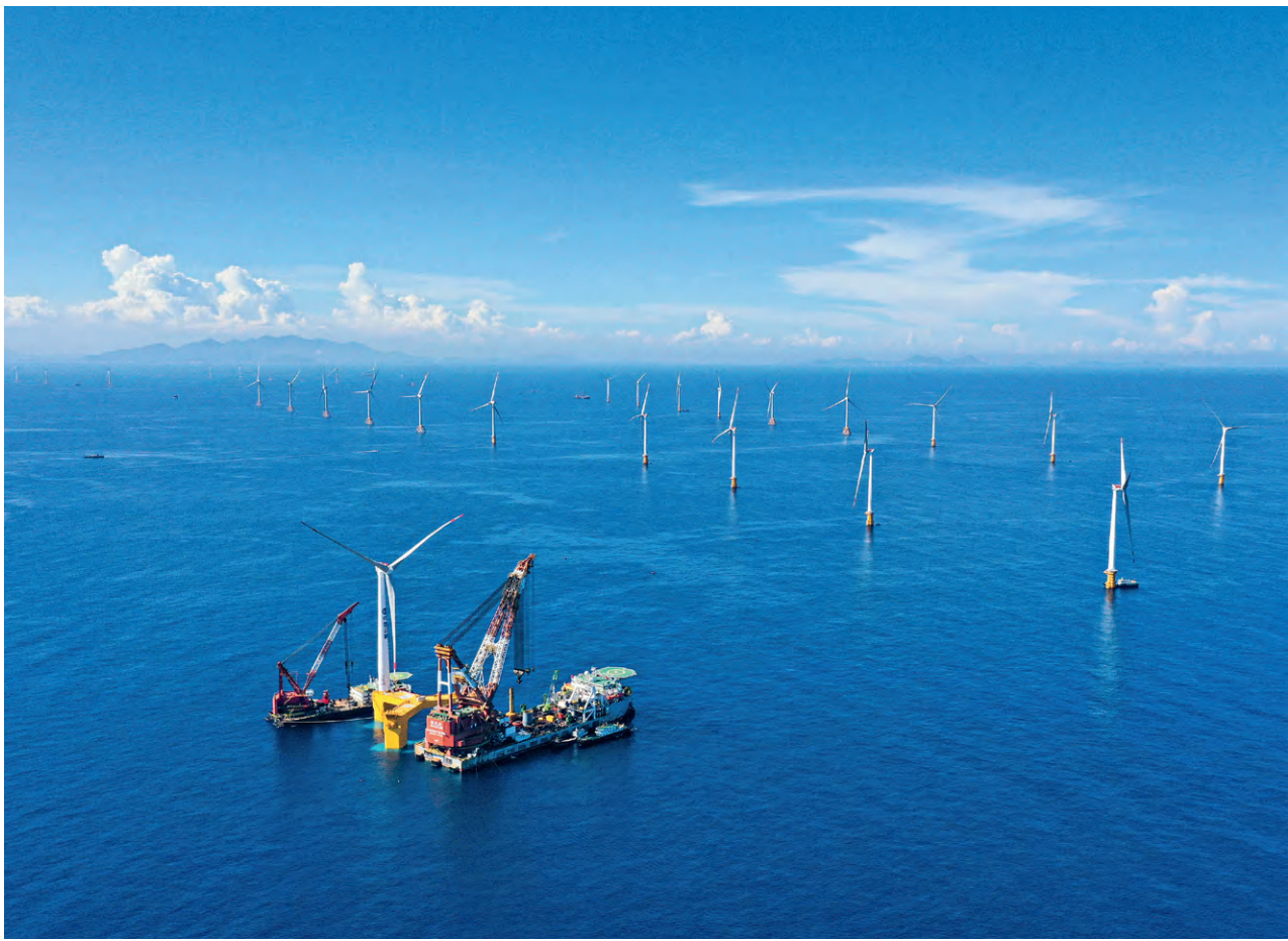
Installation de la première éolienne offshore flottante au monde à Yangjiang (Guangdong)
